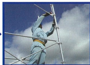
c. プレス材端部クサビを支柱ディスクに取付
