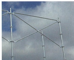
c. プレス材端部クサビを支柱ディスクに取付
