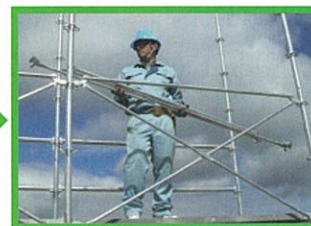
h. 折畳んで解体完了。
