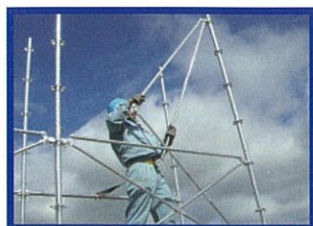
a. 上栈のフックを支柱ディスクに預ける
