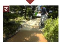
② 散水 噴霧器・ジョウロなどで散水し、表面を均一に濡らします。 表面が乾燥しないよう散水を繰り返し、全体を湿潤させます。 散水の目安は、気候によりますが、1袋あたり2~4L程度です。
